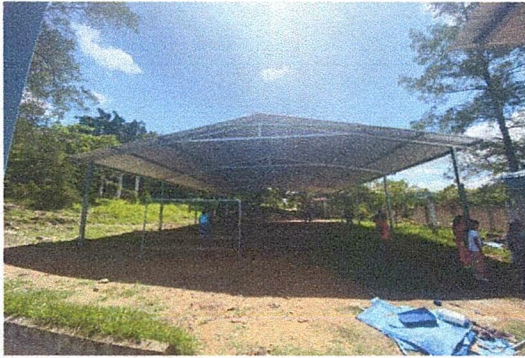
Foto 1: Primer renglón finalizado, estructura de techo para área de campo.
